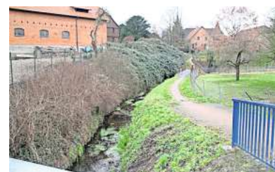
Hochwasserschutz: Dazu gehört auch das Freiräumen des Beekewegs von Büschen. FOTO: TORSTEN LIPPELT (ARCHIV)
