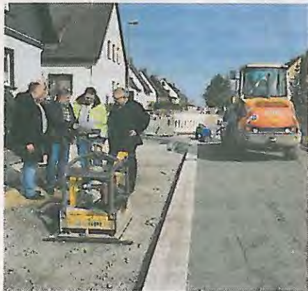
Vorfriede in Ummeln: Die Bauarbeiter sind bald weg.
