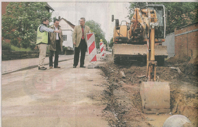
Baustellenbesprechung in der seit einigen Tagen gesperrten Kolpingstraße: Bauleiter Wolfgang Ihsen (links) erläutert dem Geschäftsführer der Ingenieurgesellschaft WIA, Salah Özkaynak, und Bürgermeister Wolfgang Moegerle die Arbeiten am Regenwasserkanal. Fot
