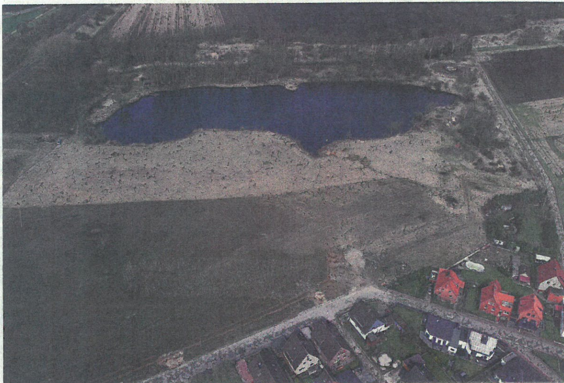
Hier entsteht das neue Wohngebiet: Auf der dunkleren Fläche zwischen dem Ziegeleiweg und dem See werden 32 Bauplätze erschlossen.
